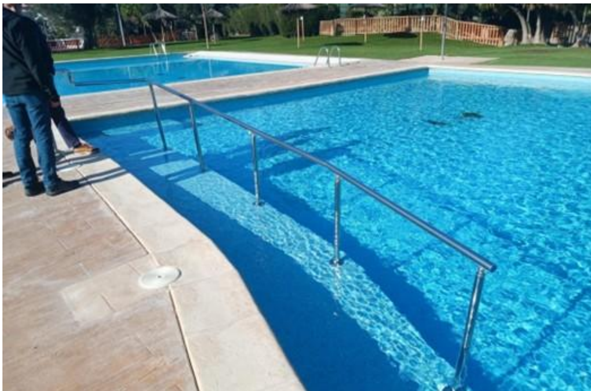
Imatge 5 Rampa d'accessibilitat de piscina N° 3
