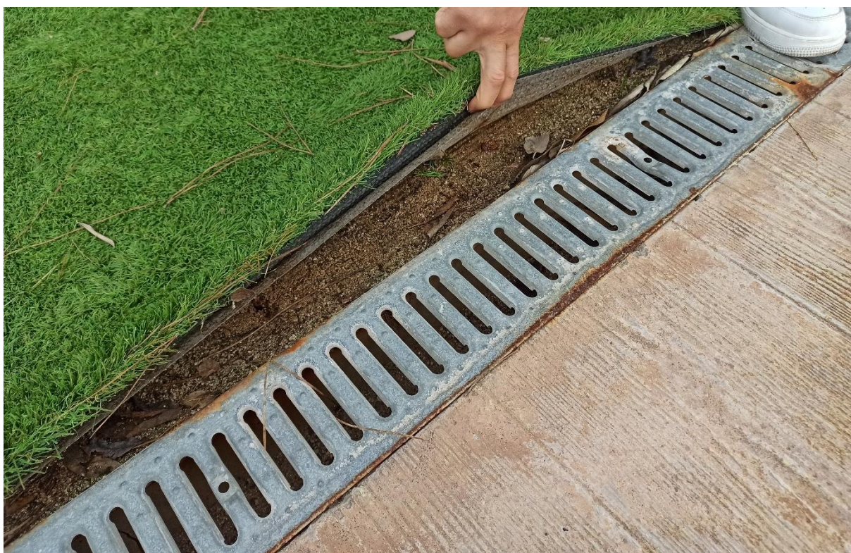
Imatge 6 Reixeta de recollida d'aigua
