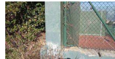
Desnivell entre l'explanada inferior (+106,72 m) i pista fronton (+99,98 m) separades pel mur de contenció de terres
